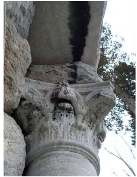
022 - Exterior masonry - SW portico masonry 5.jpg
