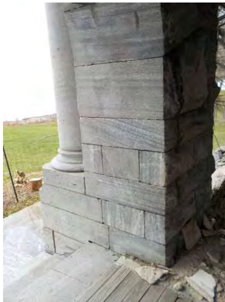
023 - Exterior masonry - SW portico masonry 6.jpg
