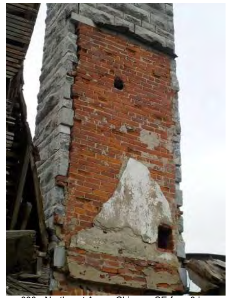
080 - Northeast Area - Chimney SE face 3.jpg
