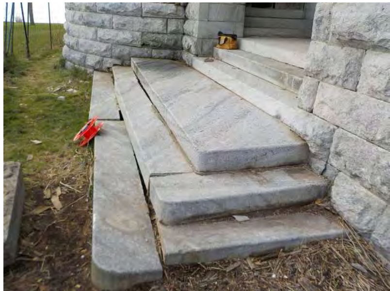
036 - Exterior masonry - SE portico steps.jpg
