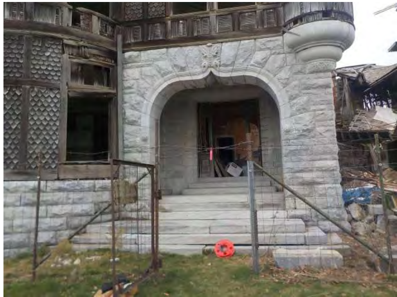
034 - Exterior masonry - SE portico.jpg
