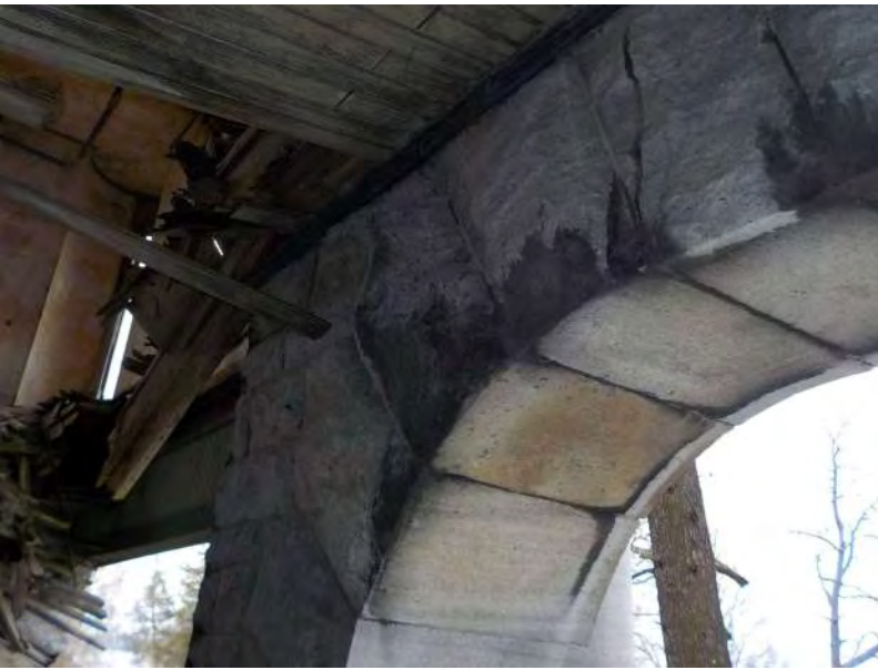
021 - Exterior masonry - SW portico masonry 4.jpg
