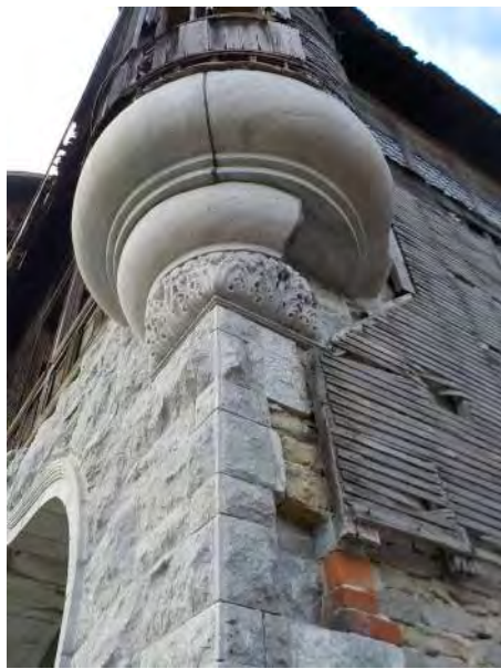
037 - Exterior Masonry - Stone turret at SE face 1.jpg
