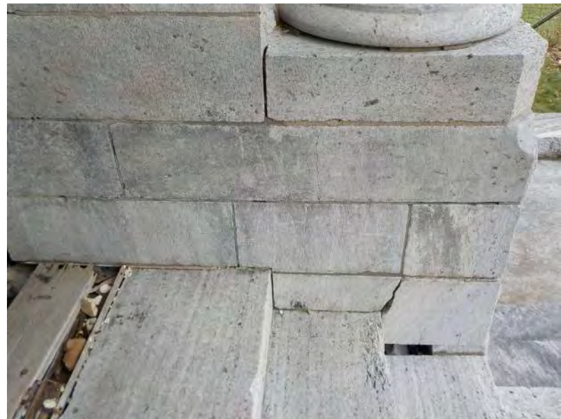
024 - Exterior masonry - SW portico masonry 7.jpg
