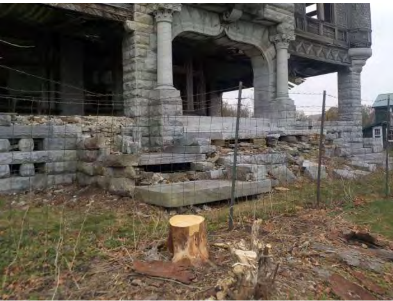
025 - Exterior masonry - SW entrance 1.jpg
