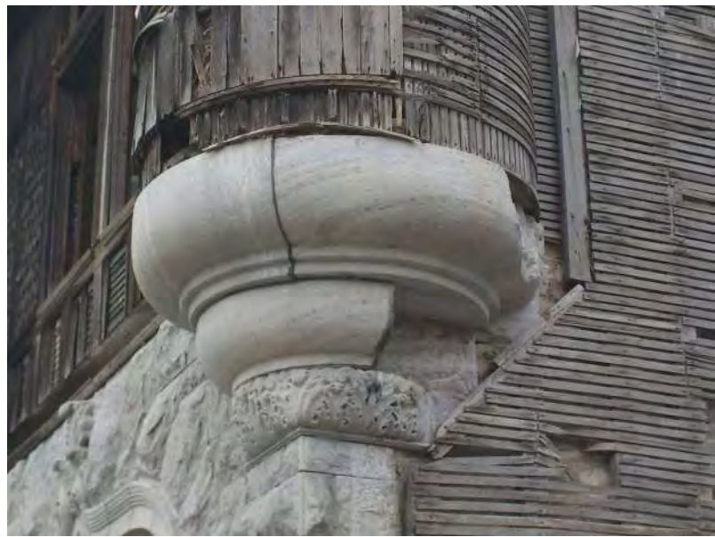
038 - Exterior Masonry - Stone turret at SE face 2.jpg
