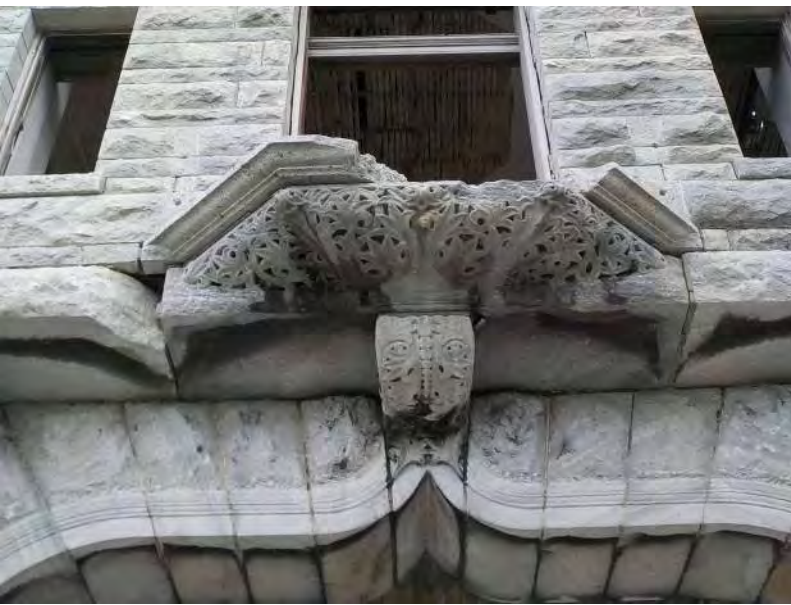
019 - Exterior masonry - SW portico masonry 2.jpg
