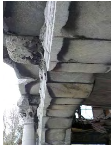
020 - Exterior masonry - SW portico masonry 3.jpg
