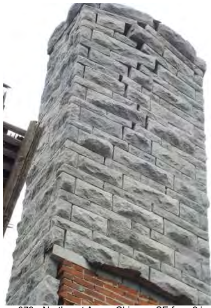
079 - Northeast Area - Chimney SE face 2.jpg
