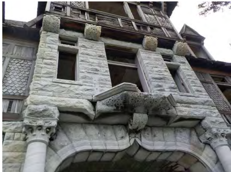
018- Exterior masonry - SW portico masonry 1.jpg
