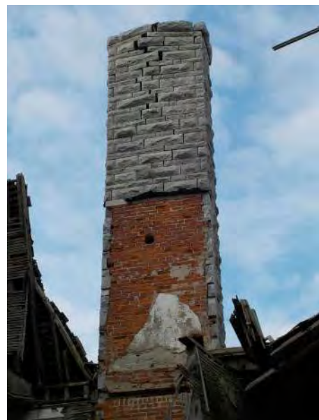
078 - Northeast Area - Chimney SE face 1.jpg
